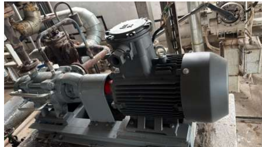
Замена насосов ЦНСн-13-70 на котельной «Орбита»
