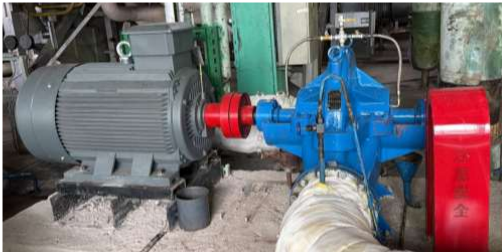
Замена насоса ЦН-400-105 на котельной «Орбита»
