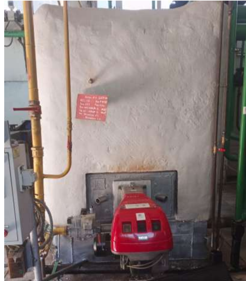
Замена котлов КСГн-1,16 на котельной Жумабаева, 36б
