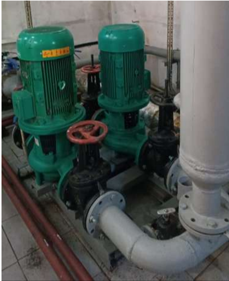
Замена насоса Д320/50 75 кВт на котельной «Школа №80»
